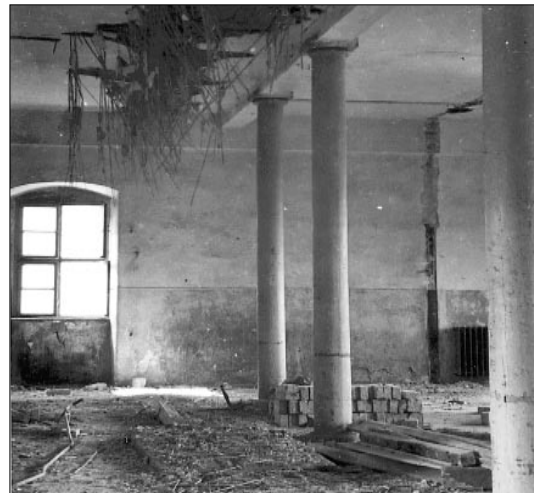
Rückbau der Säle im Haus V zu kleineren Zimmern 1959/60
