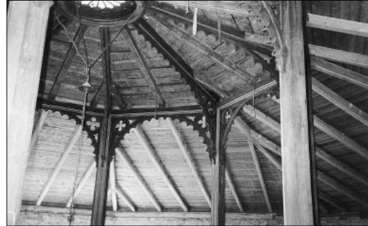
Die Deckenkonstruktion der Kirche
