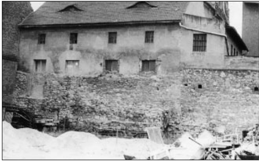
So sah der Zustand der Gebäude im Burghof mit der Stadtmauer in den 80er Jahren aus
