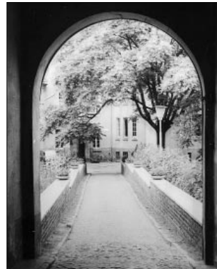
Rückgebaute Mauer ca. 1970
