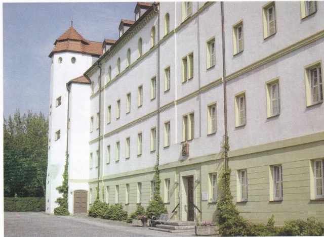
Haus Mechthild, ehemalige Zwangsarbeitsanstalt von 1804
