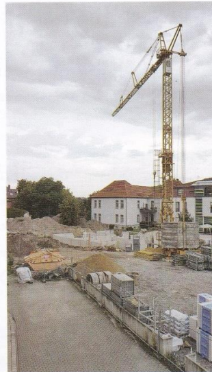
Am 31. Juli wurde bereits der Keller gesetzt
