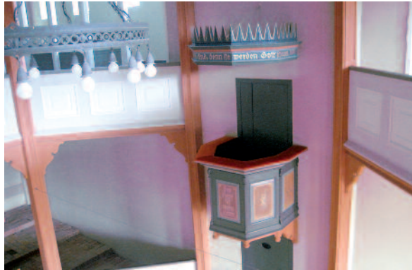
nach der Sanierung: Leuchter, Kanzel
