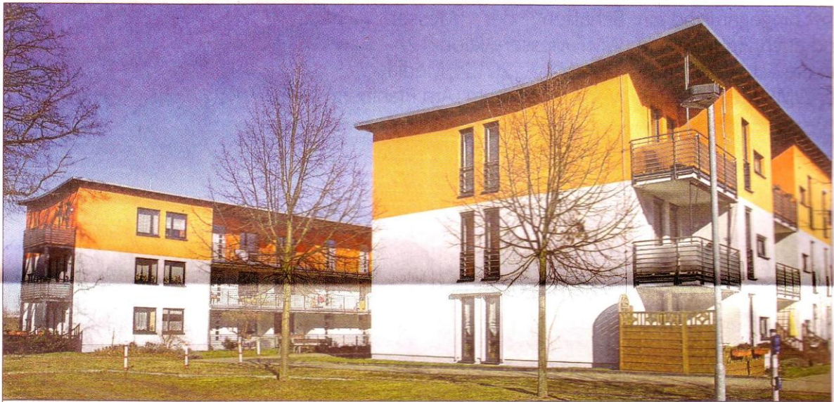
Blick vom Hof auf den Wahlitzer Wohnpark: Die Balkone werden sehr gerne von den Bewohnern und Bewohnerinnen genutzt. Fotos (2): Christian Luckau
